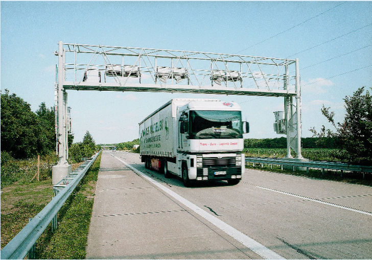
Ausschließlich für Kontrollzwecke: Toll Collect-Brücke an der Autobahn (Quelle: www.toll-collect.de )
